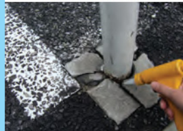
支柱、アンカーの 充填補修に
