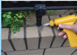
タイルの 浮き補修に
