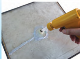
コンクリートの ひび割れ注入に
